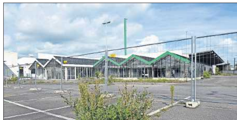
Der Sanierungsbeginn im Gewerbegebiet Sandloch ist unklar. FOTO: KUNZ
